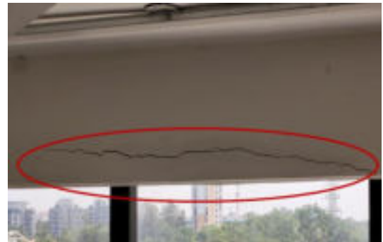
(d) Wide longitudinal crack in the side face of a beam
