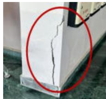
(d) Wide longitudinal crack in concrete
